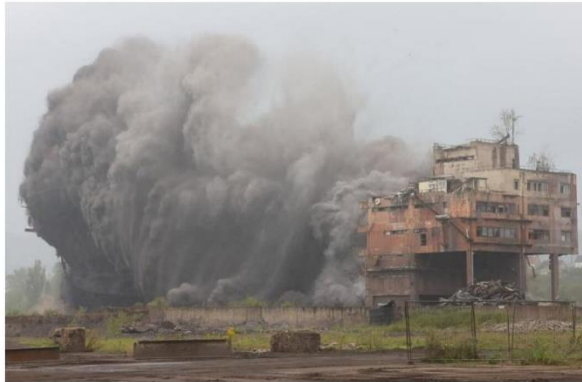
L'impressionnante démolition de l'aciérie de Gandrange. La carcasse de ce géant d'acier a été mise à terre jeudi 31 août un peu avant 19h30. Photo Gilles Wirtz
